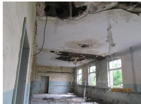
Foto 18 defekte Deckenverkleidung
