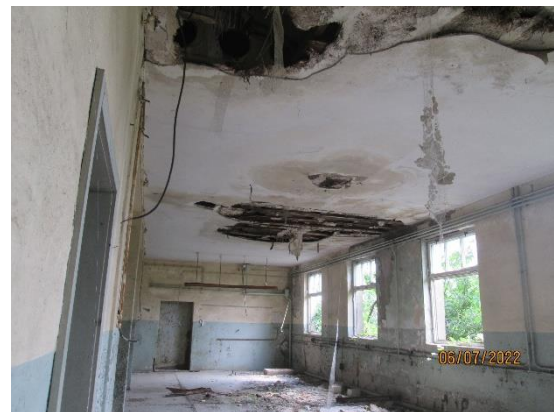
Foto 18 defekte Deckenverkleidung
