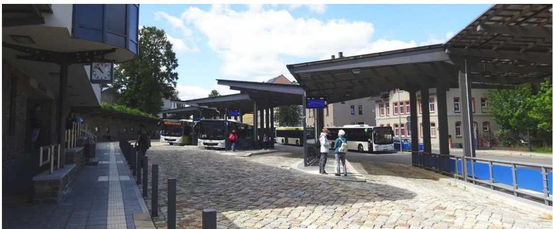
Foto: Zentraler Omnibusbahnhof in Annaberg
