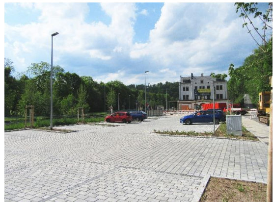
Foto: Bahnhofsvorplatz Unterer Bahnhof mit fortgeschrittenem Umbau
