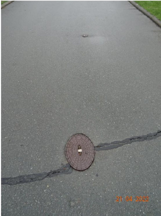
Bilder 5+6: vorhandener Unterflurhydrant
