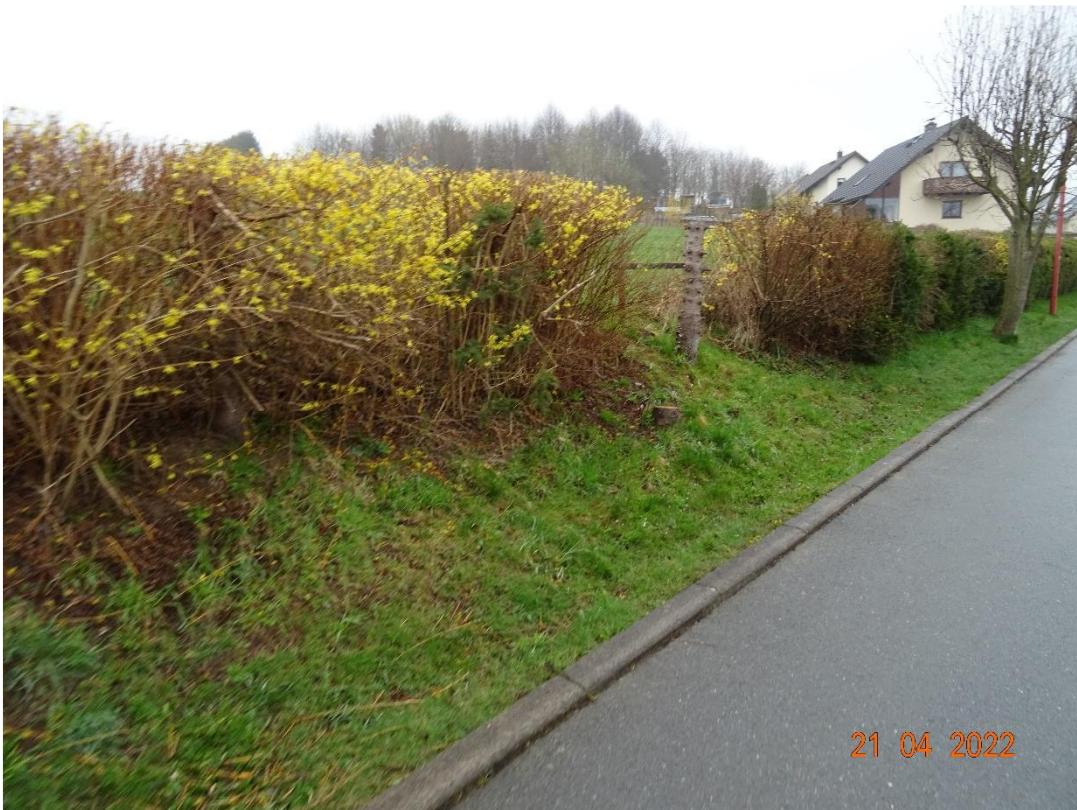
Bild 7: teilweise bewachsene Böschung an der Ringstraße, vorhandene abgesenkte Betonborde durchgehend
