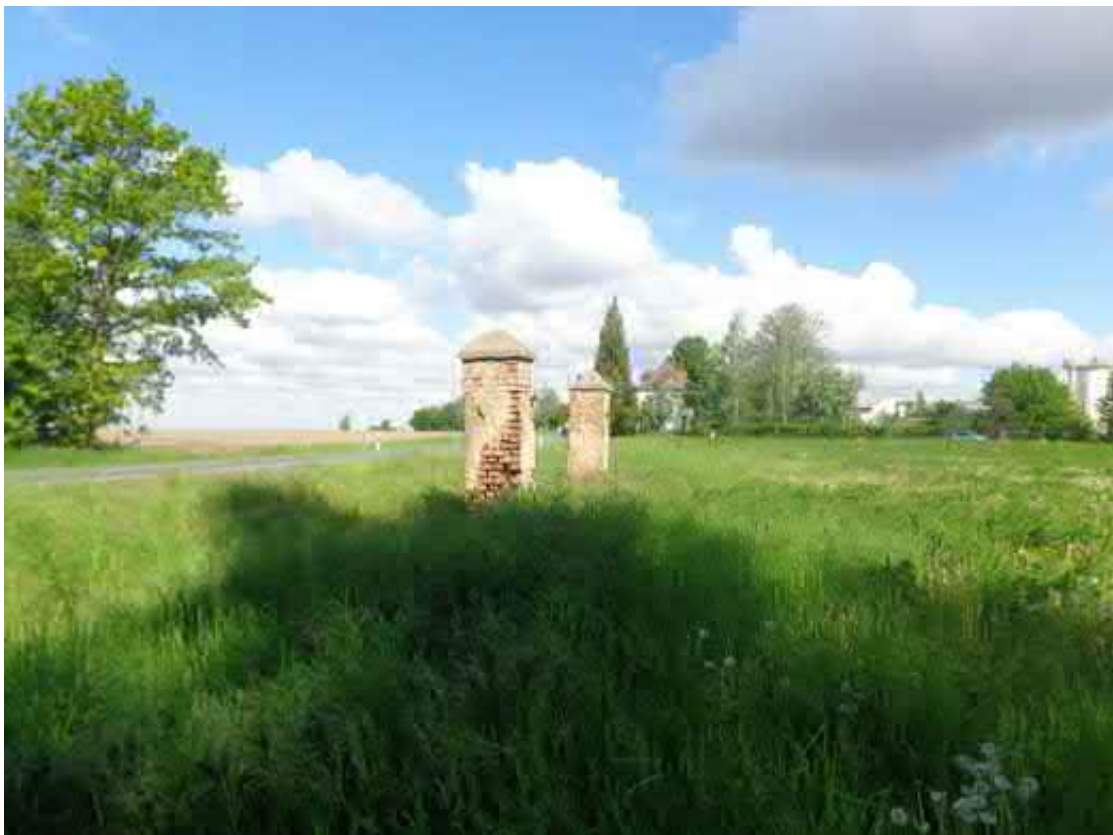
Abbildung 7: zwei Zaunsäulen aus Ziegelstein im Südwesten
